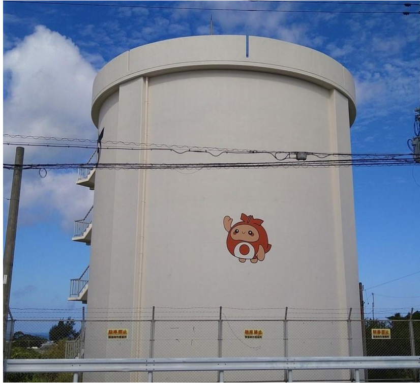
写真：上勢頭配水池
