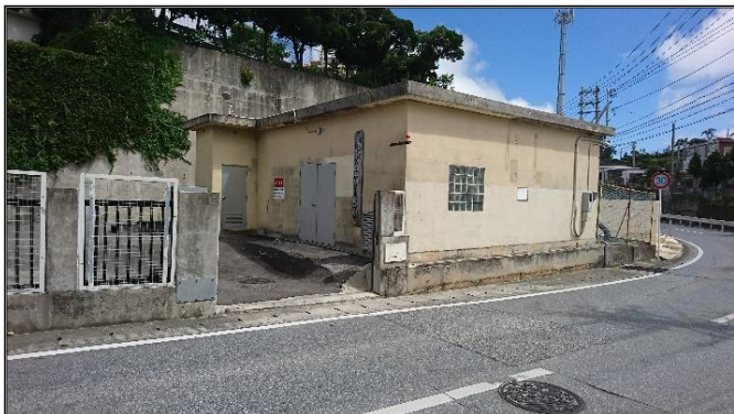
①謝苴第2 污水中継ポンプ場 (改築取組中)
