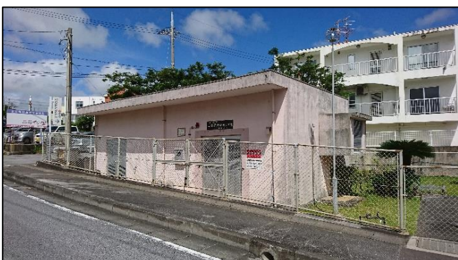
③上勢頭汚水中継ポンプ場
