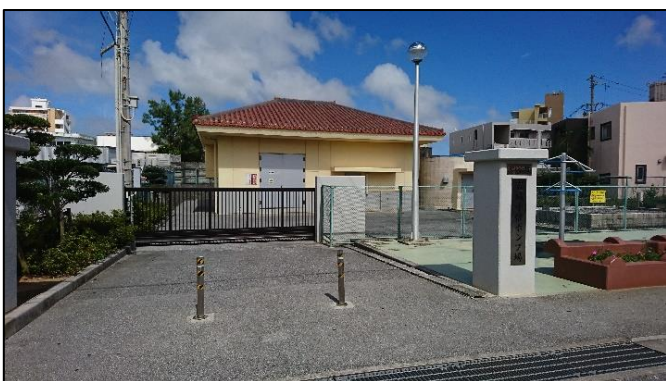
②宮城汚水中継ポンプ場
