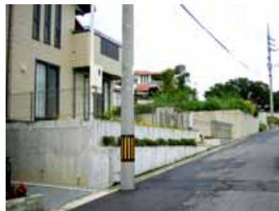
隣地擁壁の住宅例（約1.2m）
