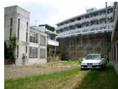
背面擁壁の住宅例（約4m）
