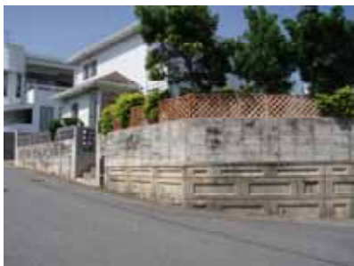
傾斜地の擁壁（緑化無し）
