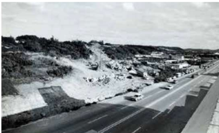
[掲載資料]写真: 30620001694 軍道1号線(国道58号)(1973年頃)
