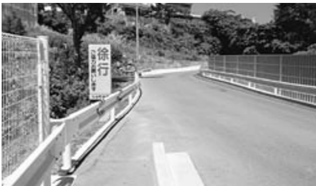
桑江17号線の歩道がない部分
